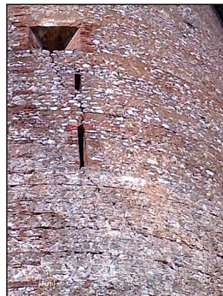
• Figure 9 : fissures verticales entre les ouvertures
