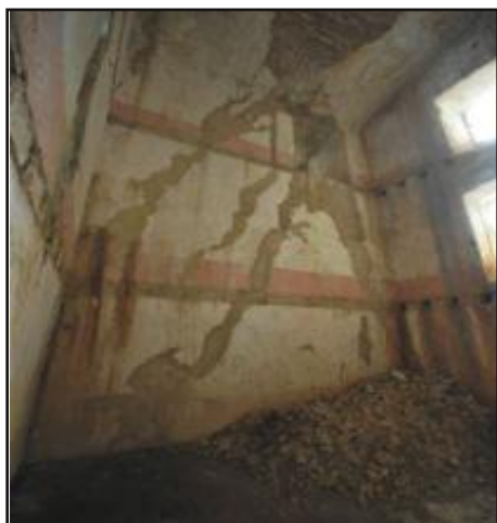
• Figure 17 : photo montrant les réparations des fissures diagonales en 1950
