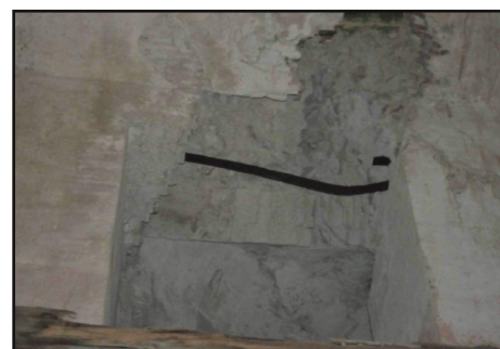
•Figure 36 : Eclatement de l'une des parois transversales qui met au jour renfort d'origine qui disloqué et tordu.
