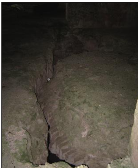
• Figure 5 : Photo montrant la dislocation des voûtes
