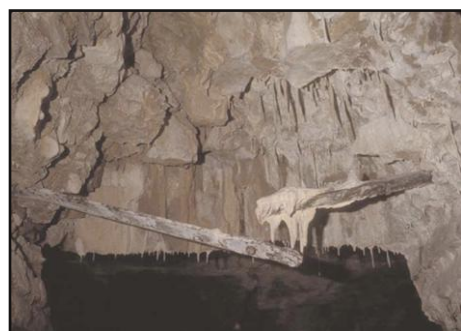
•Figure 37 : Mise au jour de barres de fer à l'intérieur de l'une des parois transversales. Ce fer constituait le renfort d'origine mais s'est déboîté.
