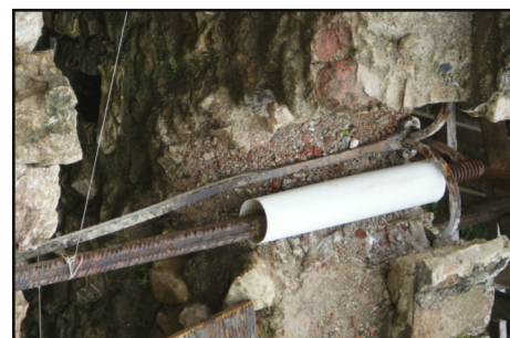
• Figure 35 : Photos montrant du côté droit les pas de vis du tirant en vue de son serrage
