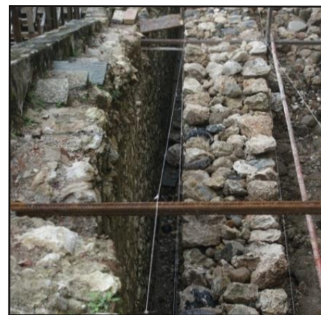
• Figure 34 : Mise en place des tirants
