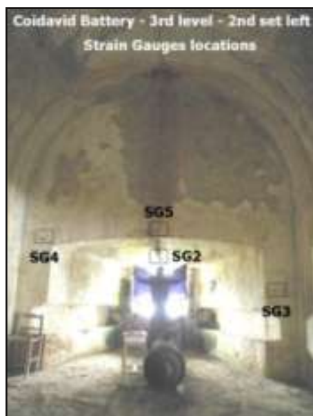
• Figure 21 : Batterie Coidavid emplacement des jauges de contrainte
