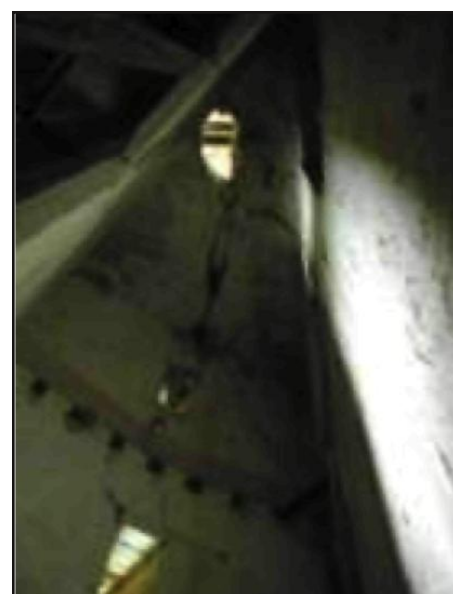
•Figure 4 : Autre vue montrant un effondrement partiel de voute
