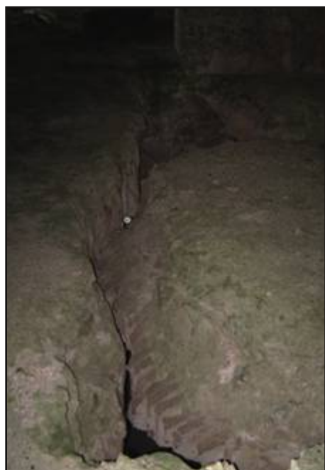
• Figure 16 : une des voûtes est complètement disloquée et légèrement déversée.
