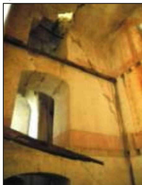
•Figure 1 : Photo montrant la fissuration des refends
