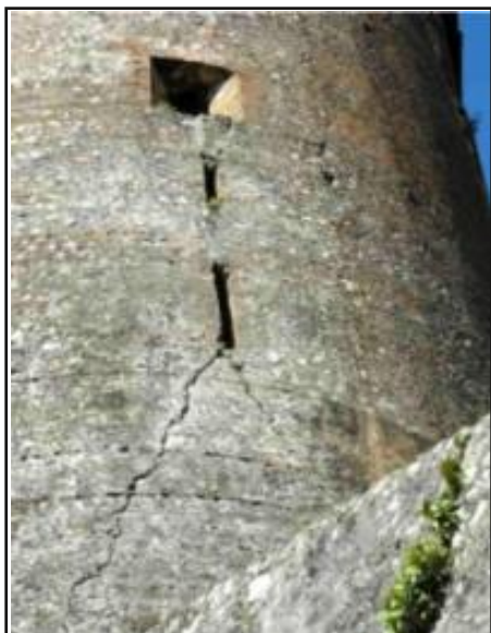
• Figure 6 : fissures diagonales dans les parements extérieurs
