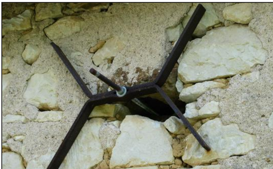
• Figure 40 : Détail de pose des tirants
