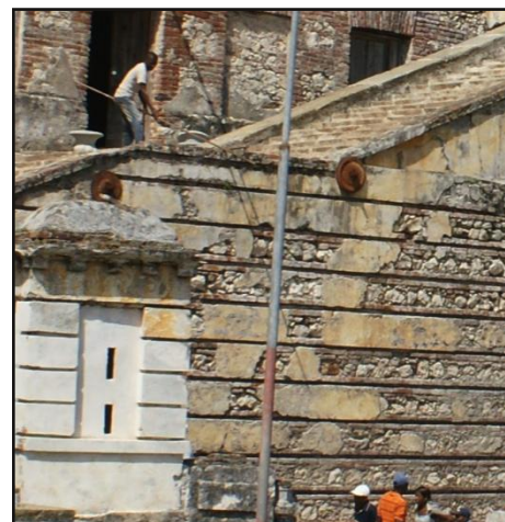
• Figure 33 : Plaques de serrage escalier monumental
