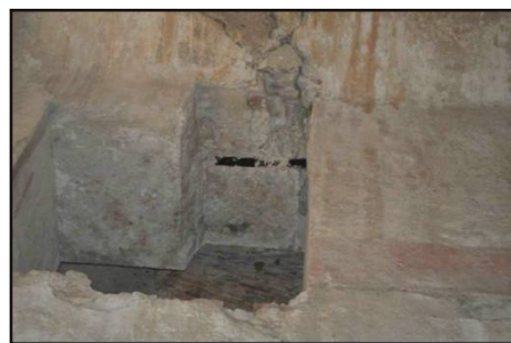
•Figure 38 : Exposition du renfort d'origine constitué par des barres de fer à l'intérieur de la paroi transversale.
