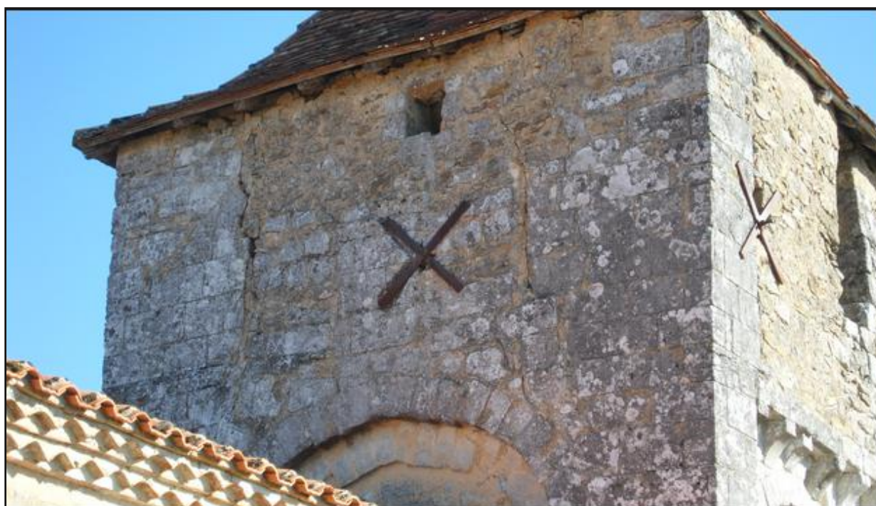
• Figure 39 : voici ce qui est envisagé pour la Pose des tirants
