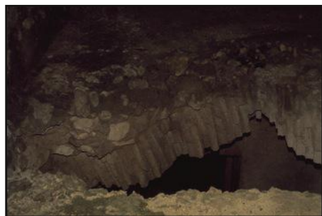
• Figure 15 : dislocation partielle des voûtes
