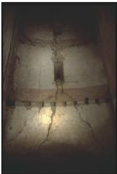
• Figure 10 : Photo montrant les fissures entre les fenêtres
