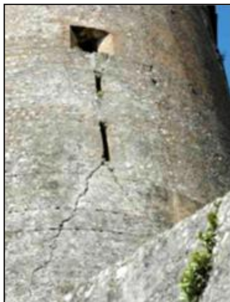
• Figure 11 : fissures diagonales dans les parements extérieurs
