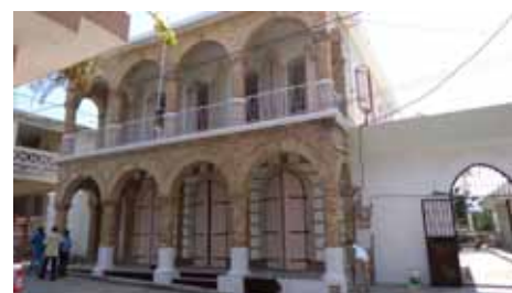
• Le Tribunal de Première Instance de Jacmel, avant et après restauration
