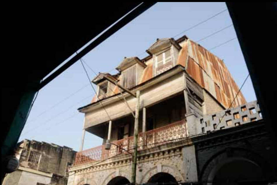
• La toiture mansardée à lucarnes du 100 de la rue Sténio-Vincent
