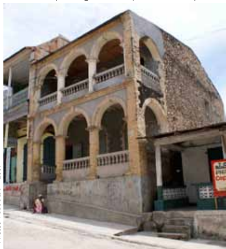
• Maison avec mur en maçonnerie porteur avec chaînage de briques (101 de la rue Margron)
