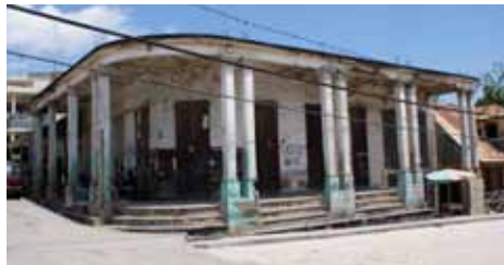
• Bâtiment avec galerie à ossature en béton (angle des rues Abbé-Huet et Brice-Ainé)
