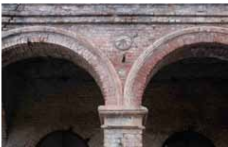
• Les galeries à arcade de maçonnerie de briques : 91, rue Sténio-Vincent et 75, rue Saint-Léger-Pierre-Louis (détail)
