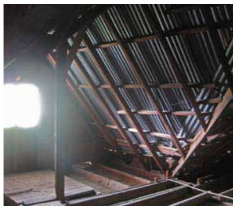
• 58 : La charpente en bois et l'espacement des pannes sablières de ce grenier ne peut accommoder qu'une toiture en feuilles de tôles ondulées, indication que les matériaux de ce toit sont des originaux.
