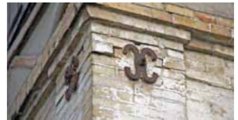
• 26 : Vue des plaques de fond décoratives dans un angle de cette construction en briques dénotant la présence d'entretoises horizontales dans les encoignures le long de chaque mur.
