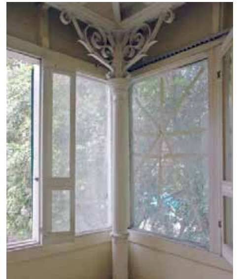
• 27 : Un exemple de motifs artistiques en ferronnerie sur les balcons du deuxième étage du Manoir. Ce travail en fer forgé est masqué par des parois extérieures en bois.
