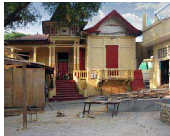
• 30 : Maison à charpente en maçonnerie masquant le style gingerbread. Unique variation remarquée de ce style qui n'a subi aucun dommage.
