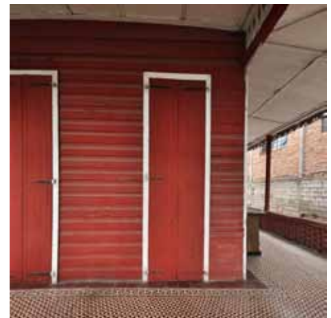
• 34 : La maison sise au 24, avenue Lamartinière montre les caractéristiques des panneaux de contreplaqué superposés des gingerbread à charpente en bois entretoisé, ainsi que la simplicité des portes dénuées de décorations répandues dans toutes les techniques de constructions et le carrelage très voyant de la galerie du rez-de-chaussée.
