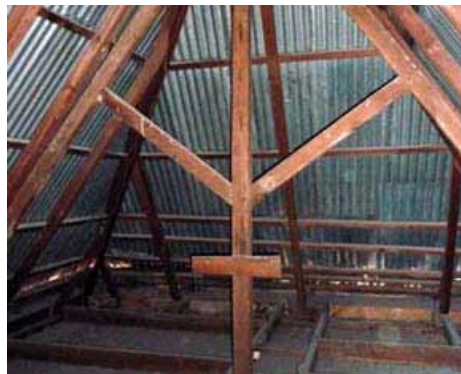
• 54 : Un toit en feuilles de tôles ondulées au-dessus des pannes sablières et la charpente en bois entretoisée.
