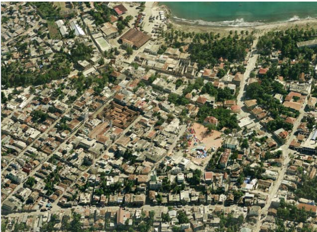
• Vue aérienne du centre historique de Jacmel
