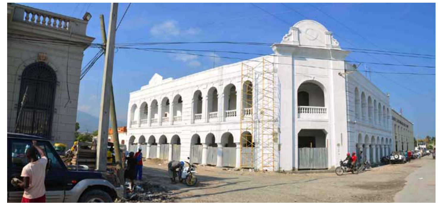
• Détail de la développée de la façade de la BNC (Document Cabinet Georges Lescot • 2011) • La BNC au lendemain du séisme (Photo ISPAN • 2010) • La façade de la BNC restaurée (Photo CIAT • 2013)
