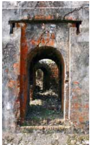
• Portail d'entrée (Redoute No 2)
