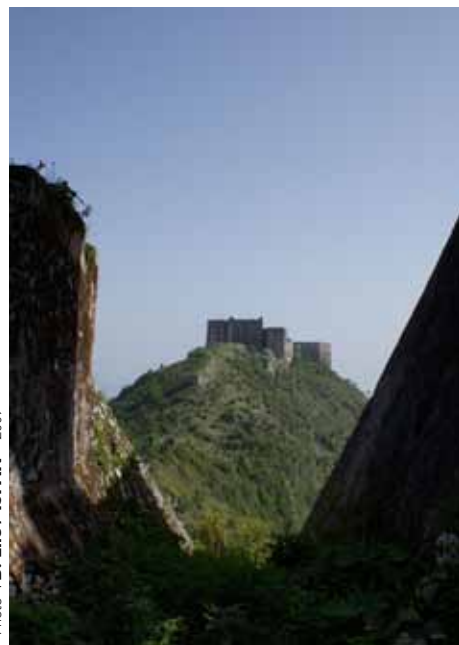
• La Citadelle Henry vue du fossé sec de la Redoute No 1
