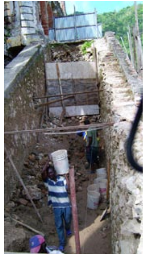
• L'enlèvement du remblai de terre meuble
