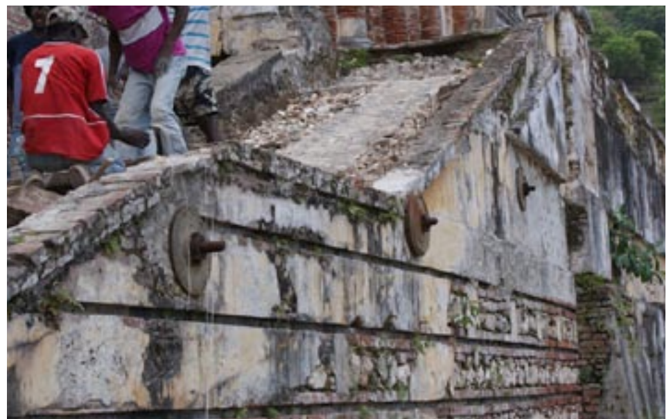
• Les plaques circulaires filettées des tirants ancrés au mur du Palais du Roi
